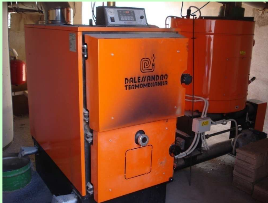
Granja porcina en Benlloch (Castellón).
