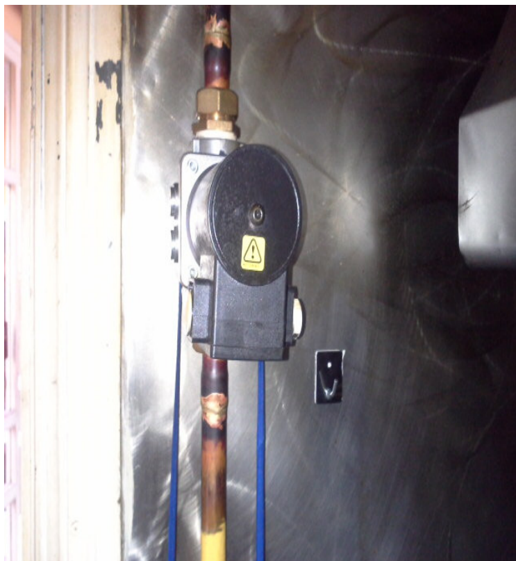
SIN CONEXIÓN ELÉCTRICA
