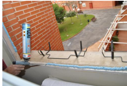
Aplicación de la espuma
