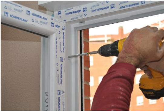
Fijación de la ventana al hueco
