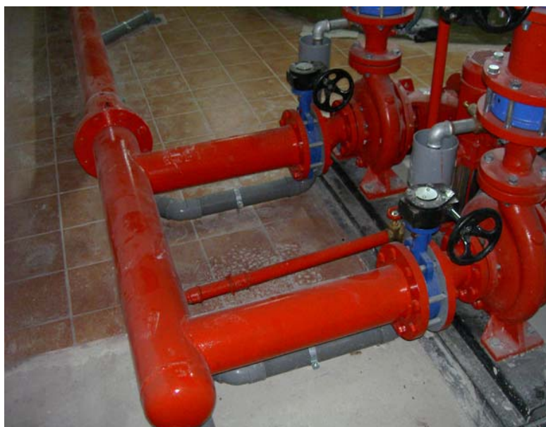
Aspiración en carga con colector
